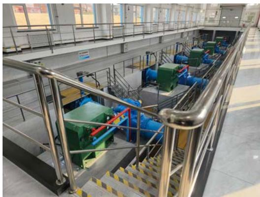
泵类、电机均置于室内利用建筑隔声
