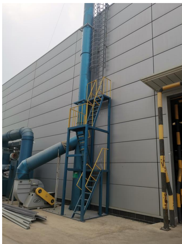
排气筒 P16 采样平台
