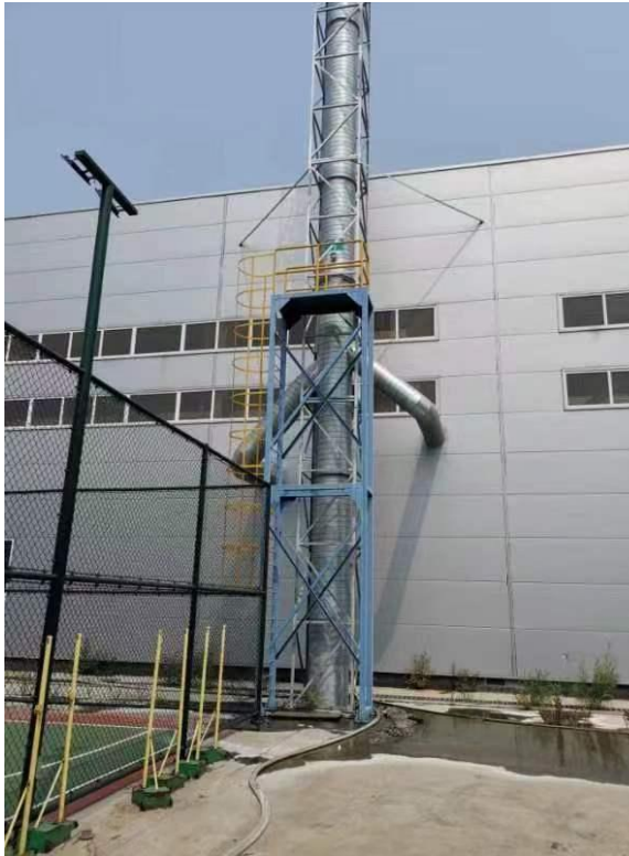
排气筒 P11 采样平台
