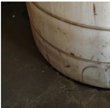
罐内地面防腐防渗
