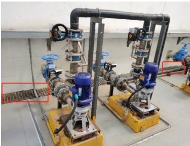
渗滤池处理池泵房收集边沟
