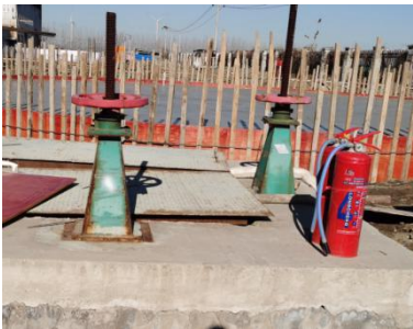
雨水收集暂存池
