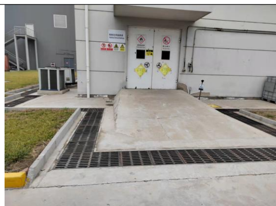
危险化学品仓库及外围排水沟
