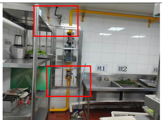
天然气报警器及手动关闭阀门
