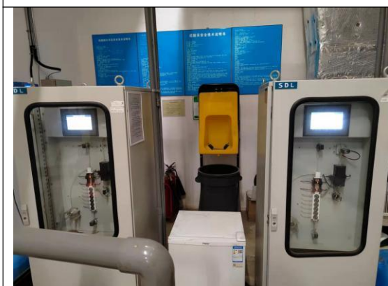
厂区北侧污水处理站在线监测实施
