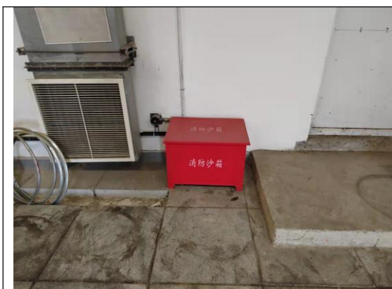
危险暂存间四周导流沟
