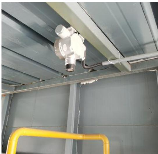
RTO 废气处理设备可燃气体报警器
