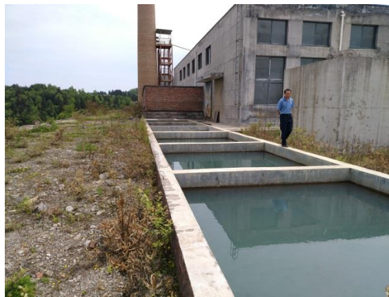
锅炉循环水沉淀池
