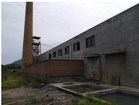
锅炉废气排放管道
