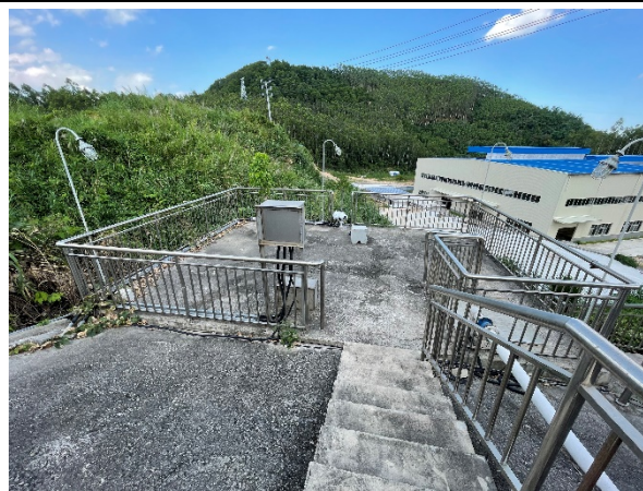
生产厂区雨水收集池
