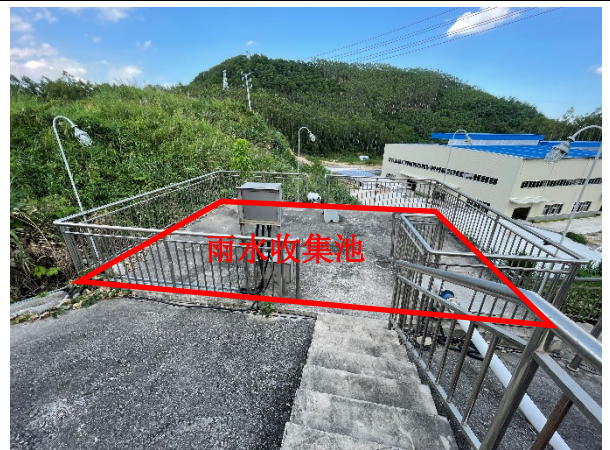
生产厂区雨水收集池
