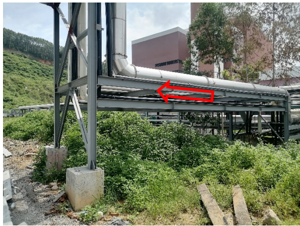
二期污水管道
