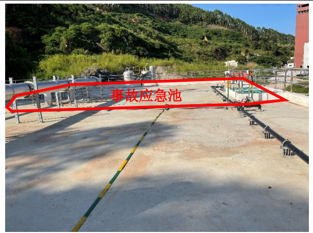
二期污水处理站事故应急池
