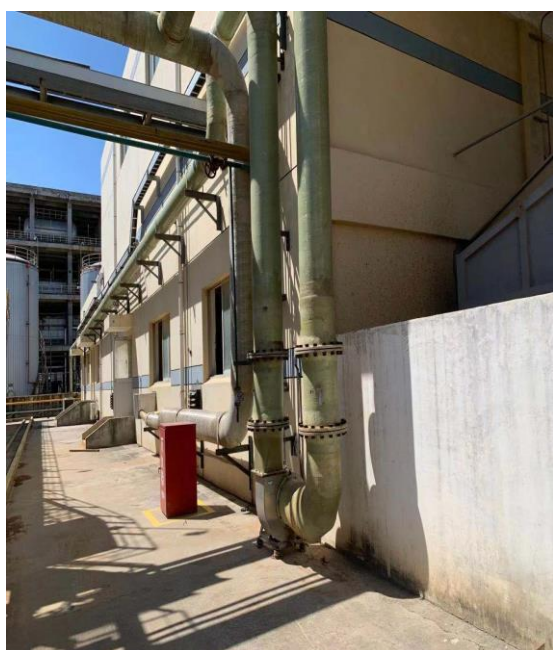
废气收集装置
