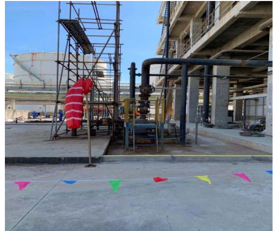
依托现有工程含油污水处理系统
