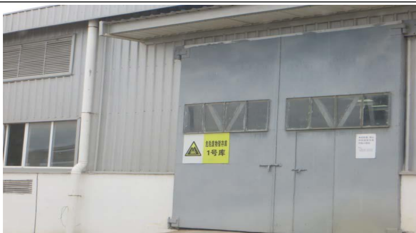
主厂区内危废暂存库（依托现有工程）
