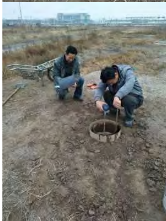
现场渗水试验
