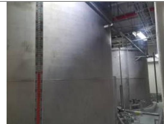
图 6.NMP 废液储罐
