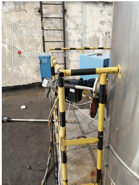
6#锅炉排气筒出口监测
