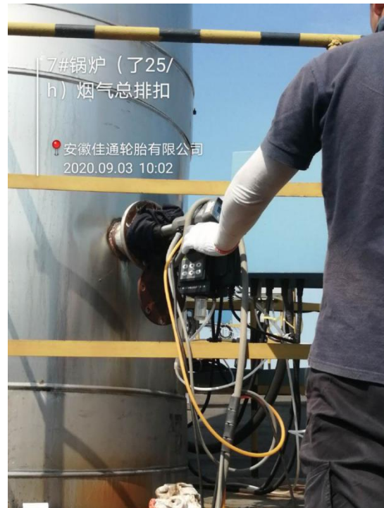
7#锅炉排气筒出口监测
