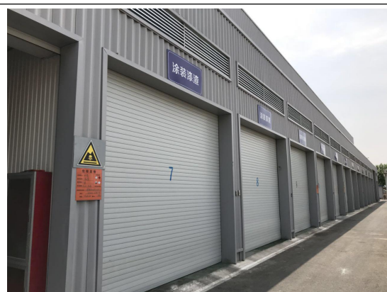
图 9 危险废物暂存场所
