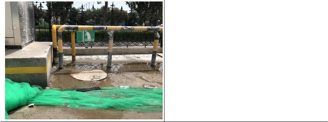
图 4 信泰公司现状废水排放口
