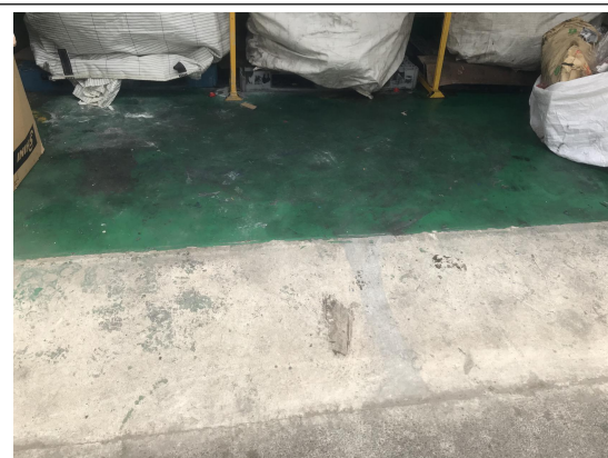
图 6 危废间门口漫坡
