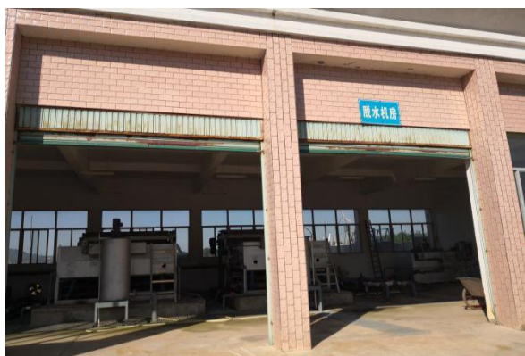
带式脱水机房
