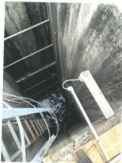
污水处理厂进口
