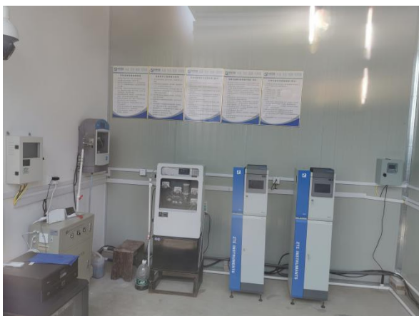
在线监测室 (pH、COD、TP、TN、NH 3 -N 已联网)
