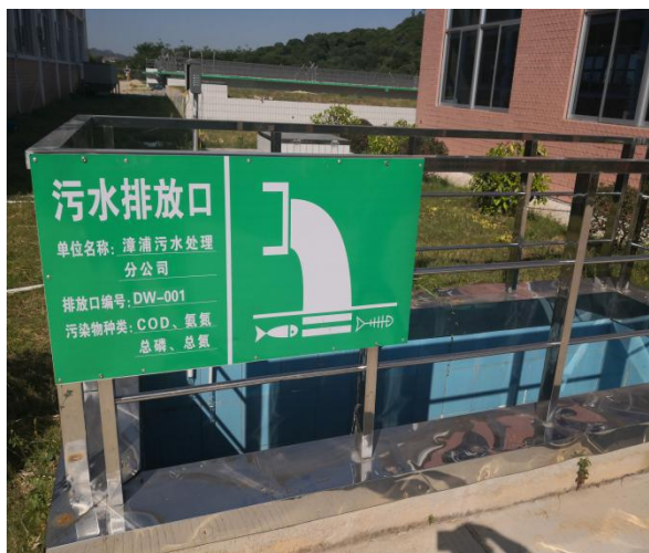
污水总排放口
