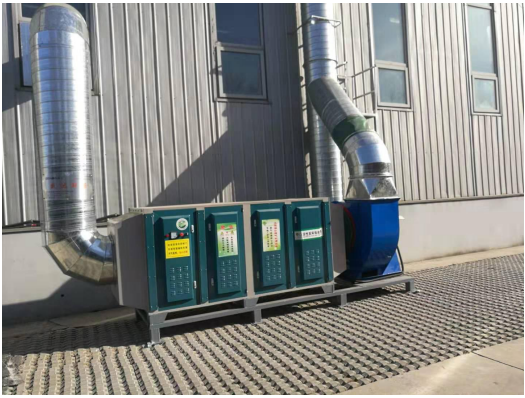
图 1.UV 光催化氧化设备+活性炭吸附装置
