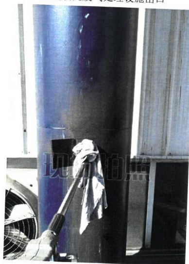
二线抛丸废气处理设施出口
