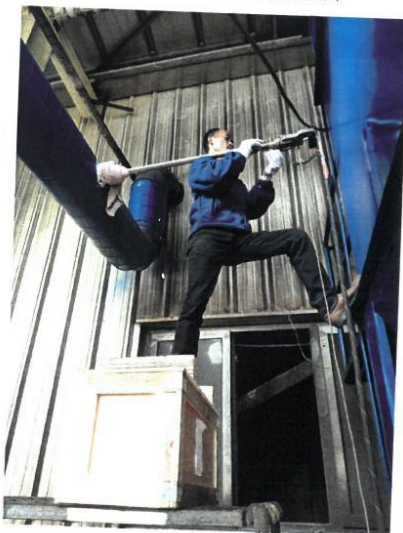
二线喷丸废气处理设施进口
