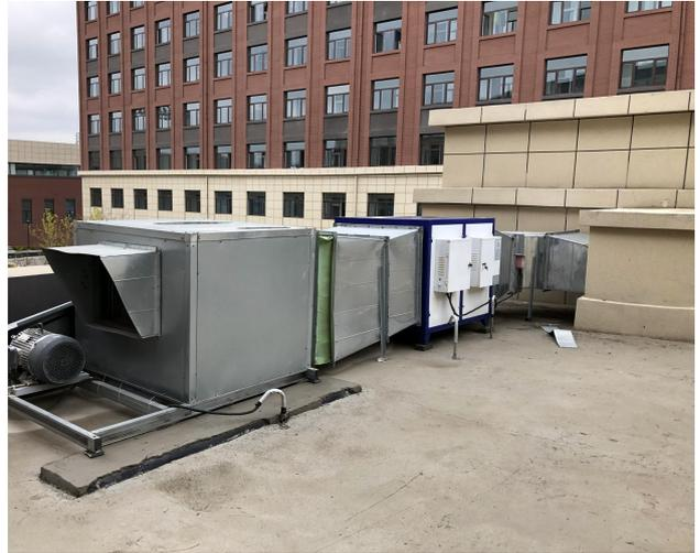
图6 油烟净化装置
