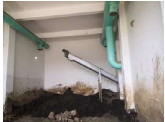
干化污泥暂存间
