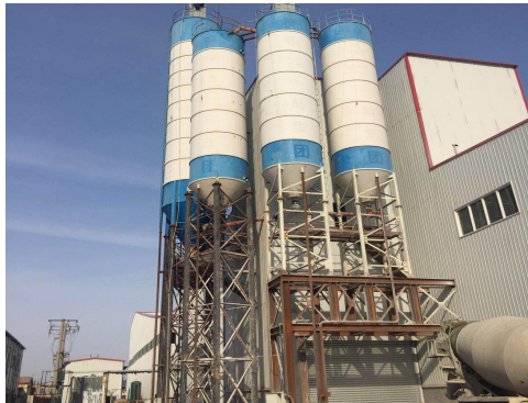
图13 水泥粉料仓（左→右分别为： 2个水泥仓+2个矿粉仓+1个粉煤灰仓）
