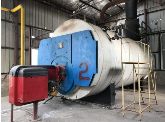
图16 新建燃气锅炉
