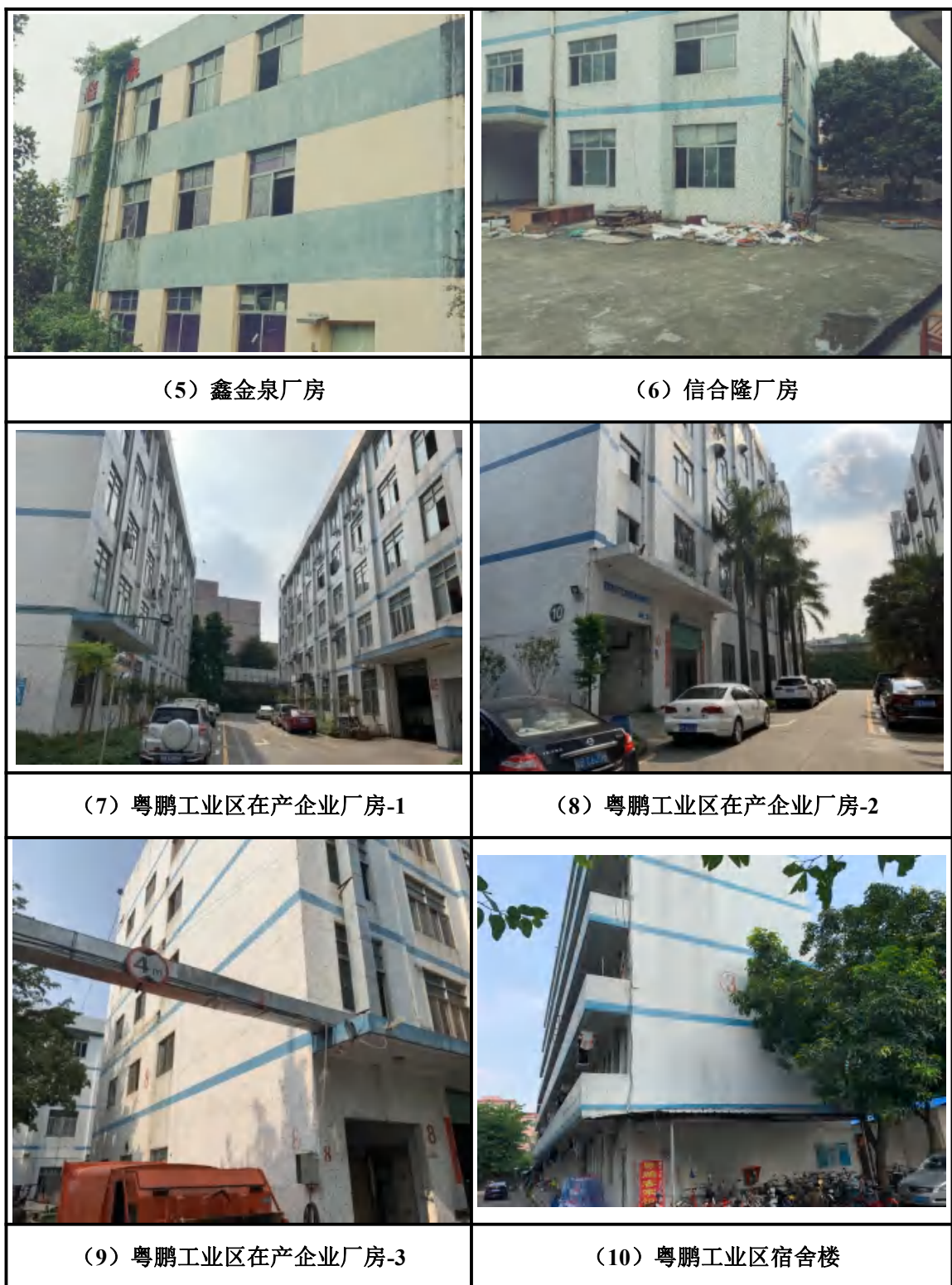
图 2.1-2 本更新单元现场踏勘照片
