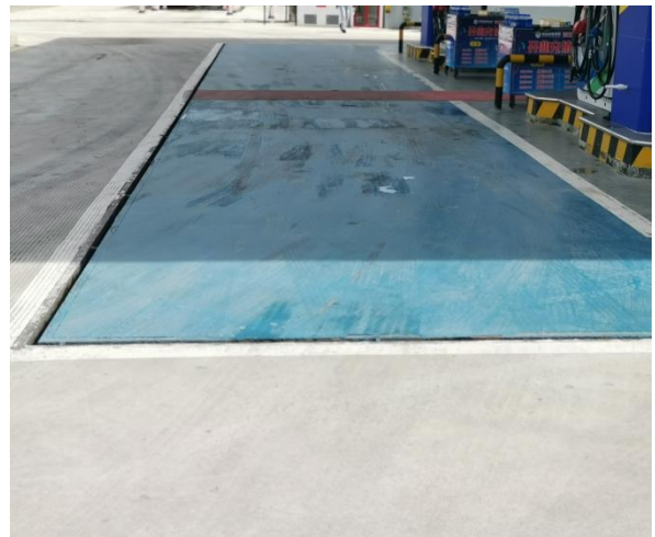
加油区地面防渗及导流沟
