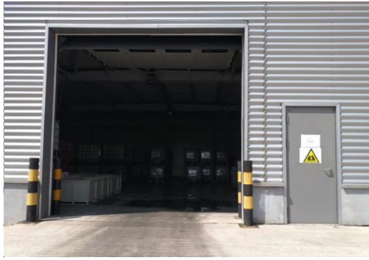
危废暂存库外部
