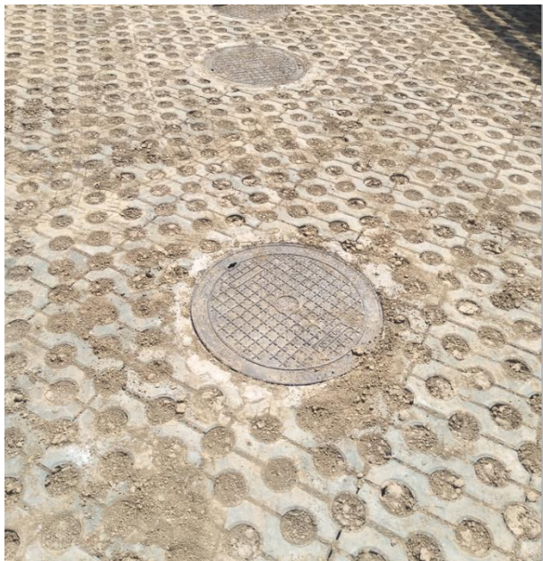
一期项目原有化粪池
