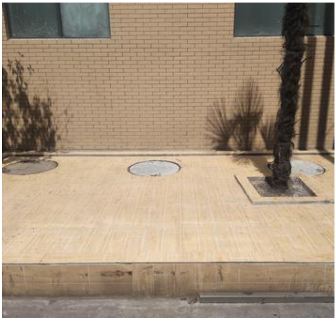
一期项目原有隔油池
