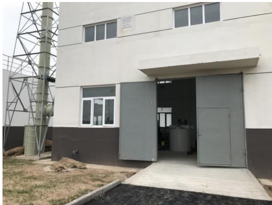
图13 加药及除臭间
