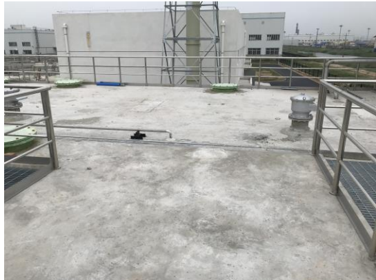
图8 臭氧接触氧化池
