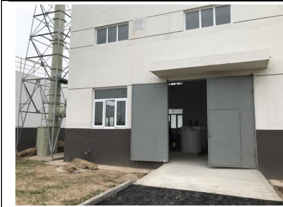
图3 密闭污泥脱水间
