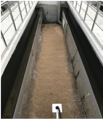
图7 深床反硝化滤池
