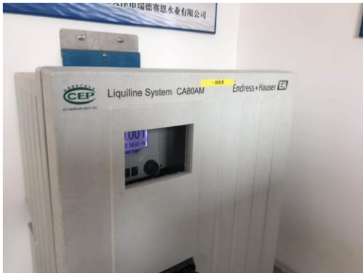
图13 一期氨氮在线监测设备
