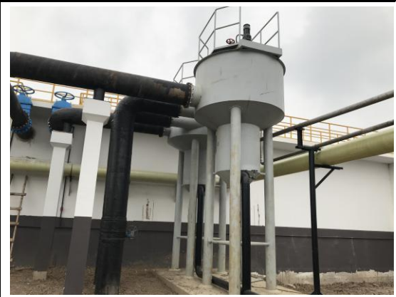
图4 密闭旋流沉砂池
