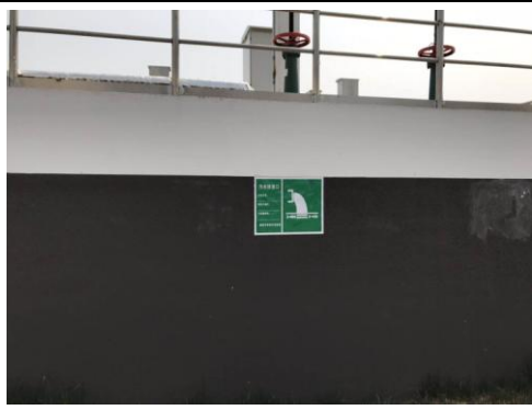
图4 出水池排放口标识牌
