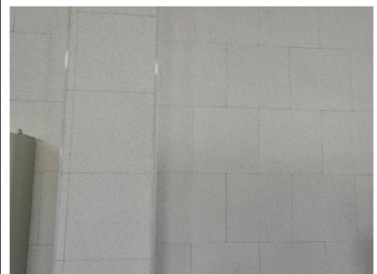
图 36 鼓风机房采用吸声墙
