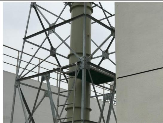
图 24 废气排气筒 P<sub>2</sub> 采样平台及采样位置
