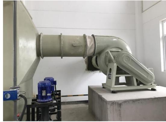
图 38 除臭风机采用基础减震及软连接措施
