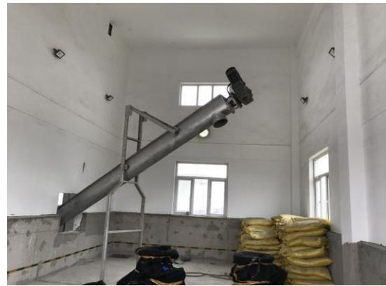
图 40 脱水污泥出泥口
