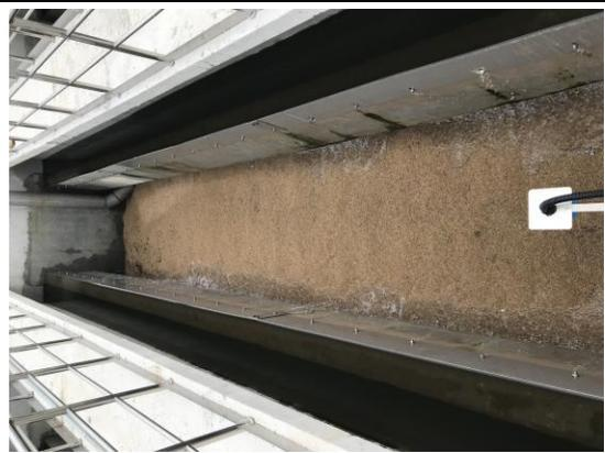
图7 深床反硝化滤池
