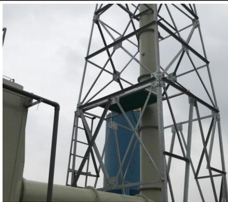
图 23 废气排气筒 P<sub>1</sub> 采样平台及采样位置
