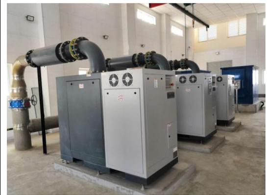
图 34 鼓风机房需用低噪声的空气悬浮风机
