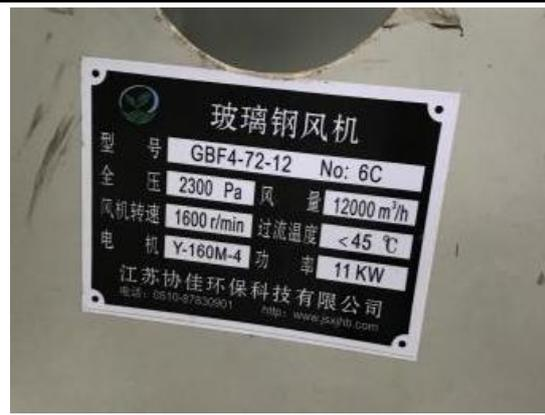
图 20 2#生物除臭装置风机铭牌
