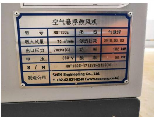
图 35 空气悬浮风机标示牌
