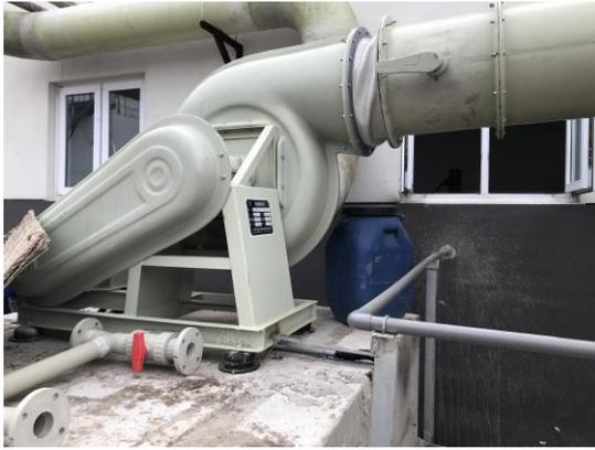
图 37 除臭风机采用基础减振及软连接措施
