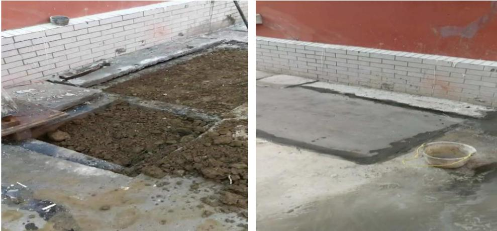
图1 厂房北侧拆掉水龙头及封闭水池
