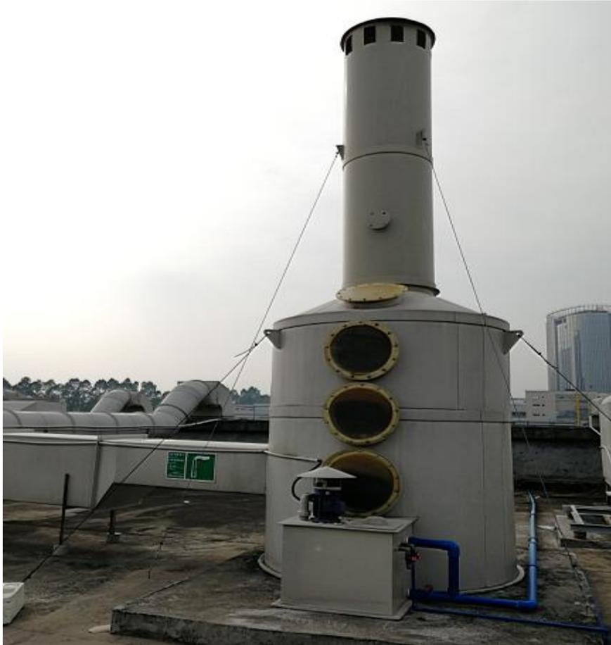
废气处理设备（水喷淋设备）
