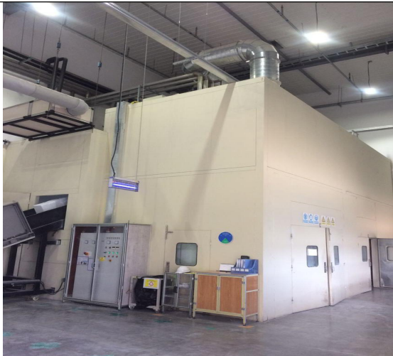
内胆破碎除尘房
