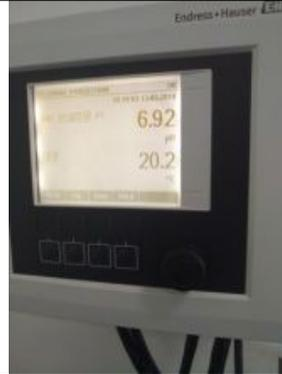
图 18 pH 在线监测装置
