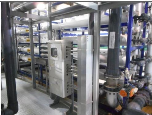
图 3 原水反渗透装置
