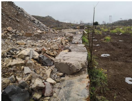
剥离土围挡墙
