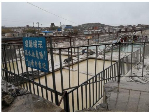
1#车间切割废水收集沉淀池
