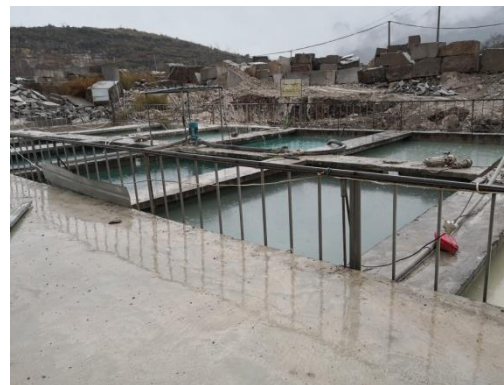
2#车间切割废水收集沉淀池
