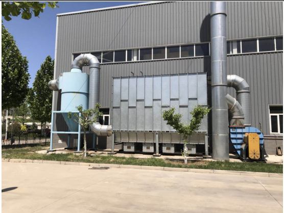
图2.抛光工序除尘设施及配套排气筒P 5
