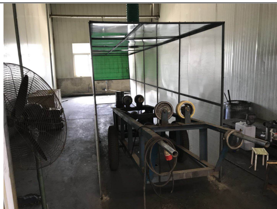
图7.涂胶设备及废气收集工位
