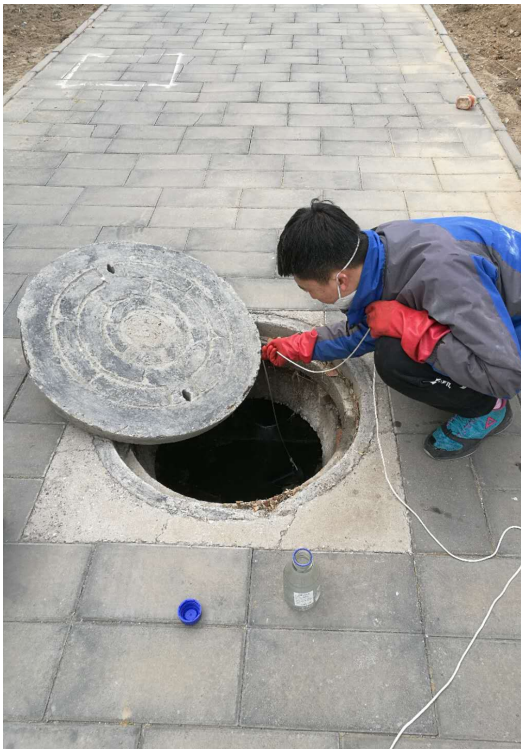
图9.厂区废水总排放口W 总
