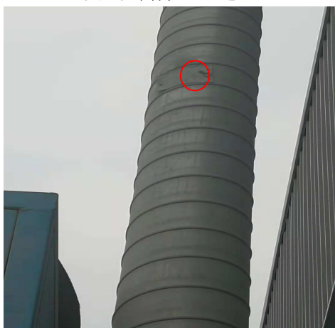
图4.布袋除尘器进口
