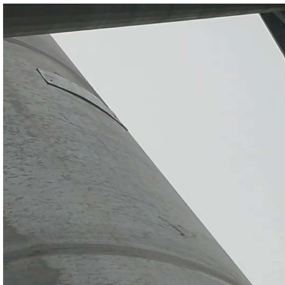
图1.滤筒除尘器进口
