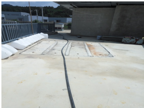
地埋式化粪池
