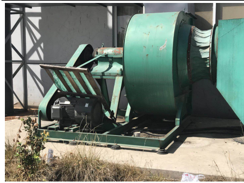
图 3 软连接及减振基础
