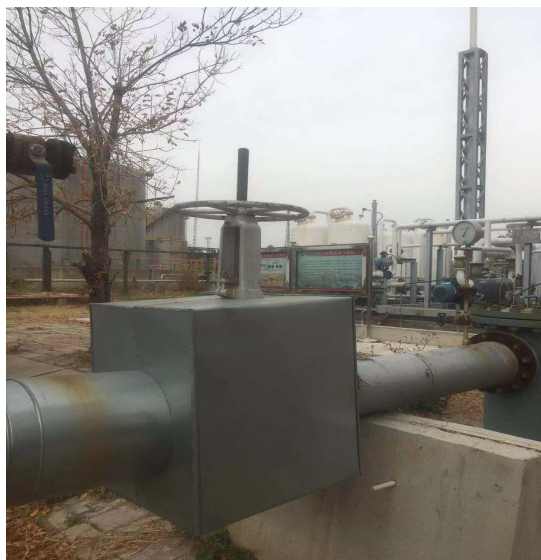
图1 总管处切断阀门
