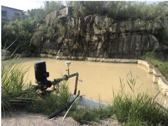
工业用水收集水池
