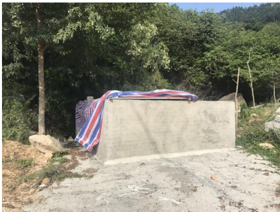
生活污水收集池
