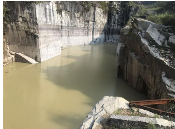
天然矿坑雨水收集池
