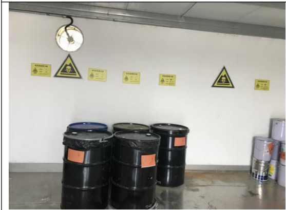
图 3 危废暂存间内部
