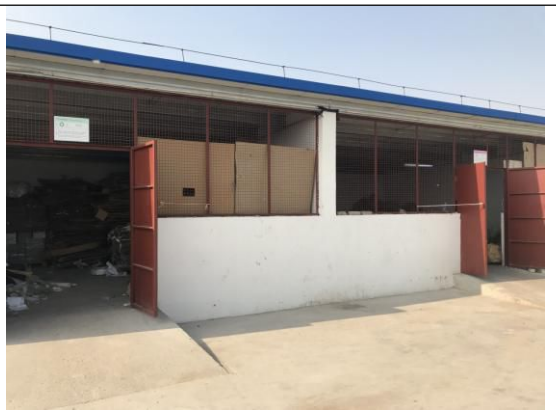
图 6 一般固体废物暂存场所
