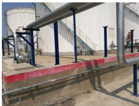
图5 罐区围堰
