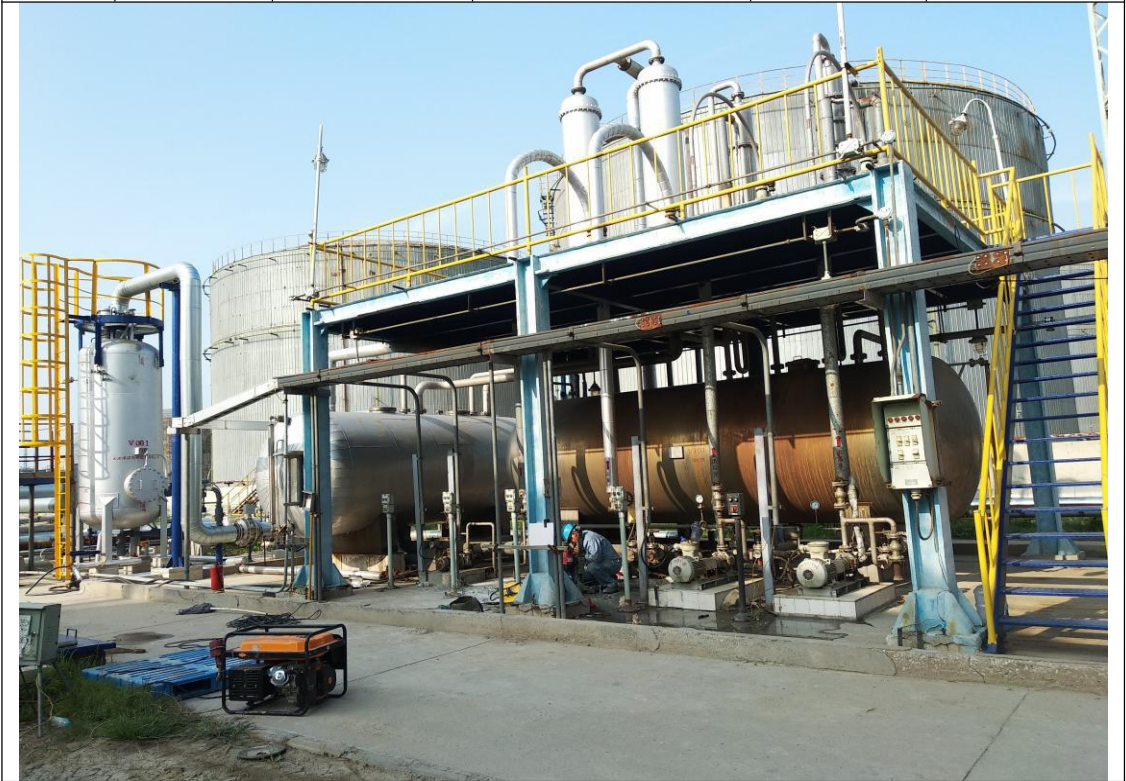
图 1 本项目处理装置区
