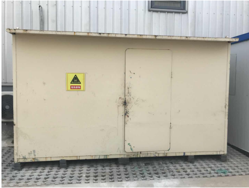
图1 危废暂存间外部照片
