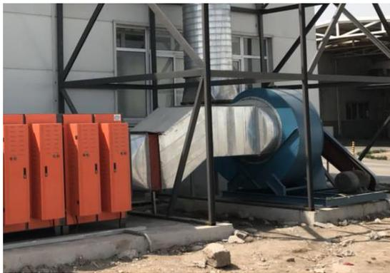
图 1 管道软连接
