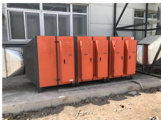
图 6 低温等离子协同 UV 光解装置
