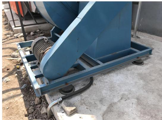
图 2 风机减振基础
