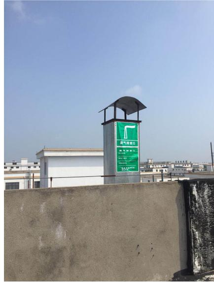
粉碎、干燥混合废气排气筒
