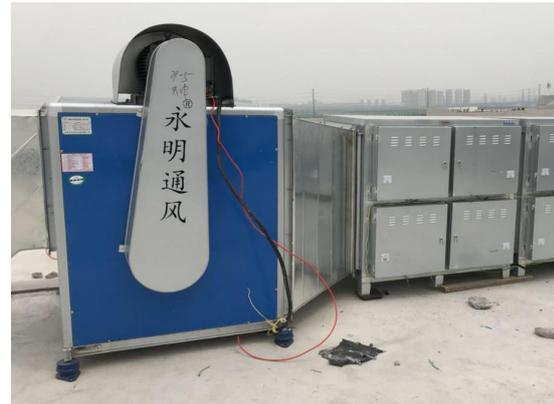
图 2 风机减振基础
