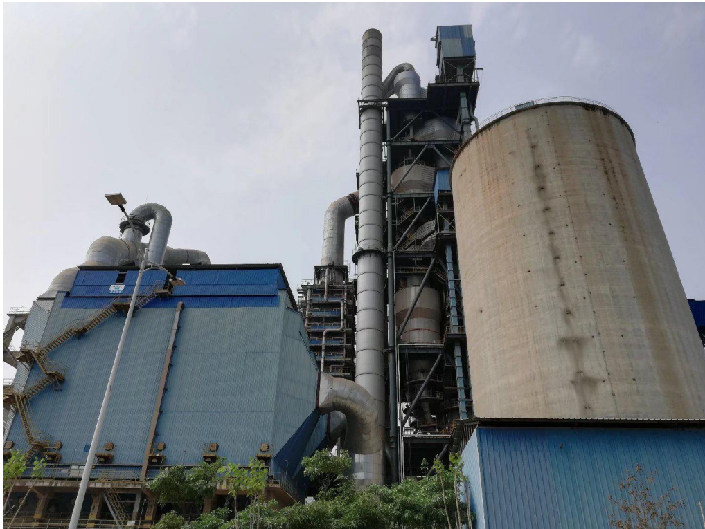
图 3.2-1 依托项目窑尾废气处理设备及烟囱
