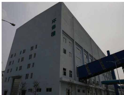
图 4.1-14 封闭的预处理车间外部
