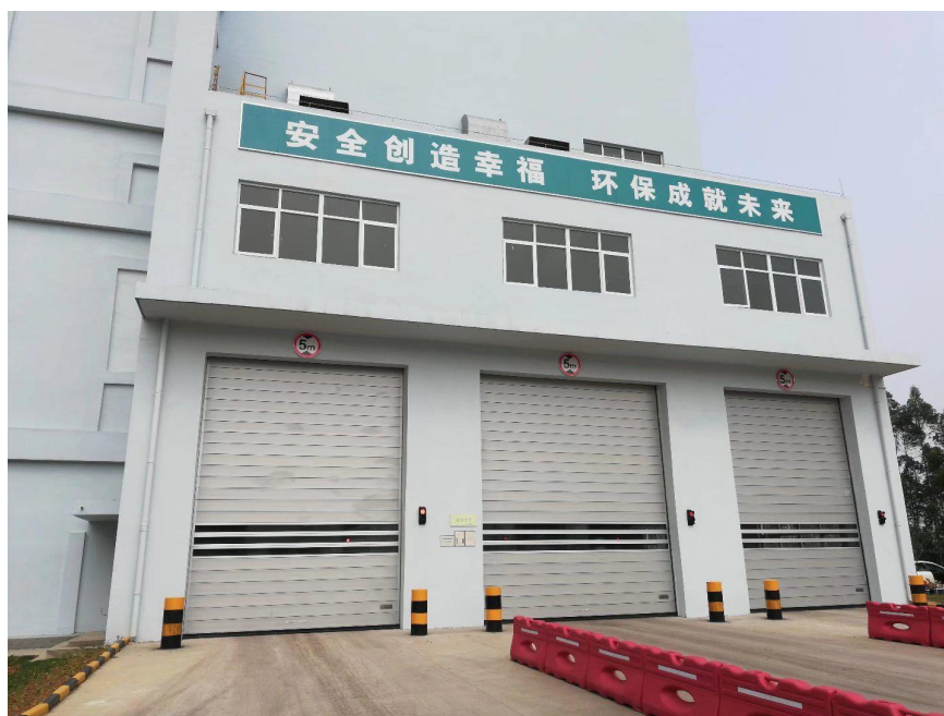
图 4.1-10 卸料平台第一道电动门
