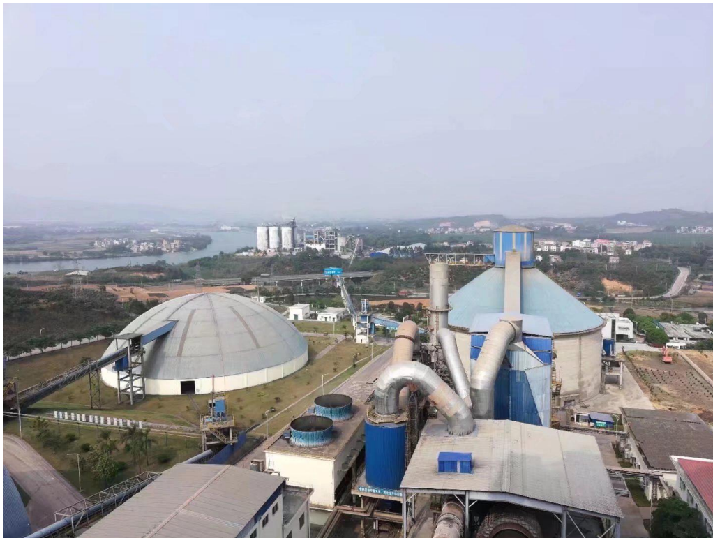
图 3.2-2 依托项目熟料烧成及储存系统
