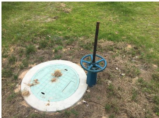
图 4-17 雨水应急切换阀门
