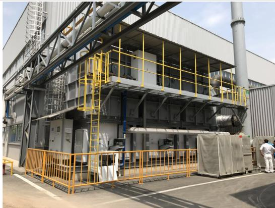
图 5 涂装一线新建 RTO 装置
