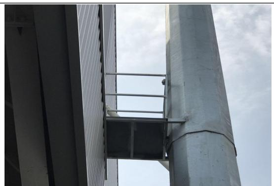
图 5 注塑废气监测孔、监测平台
