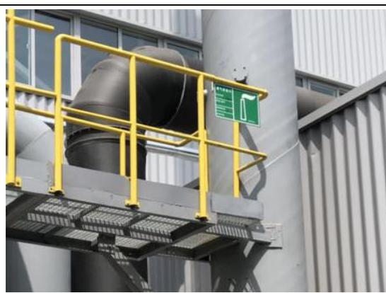
图 2 涂装一线废气监测孔及标识牌
