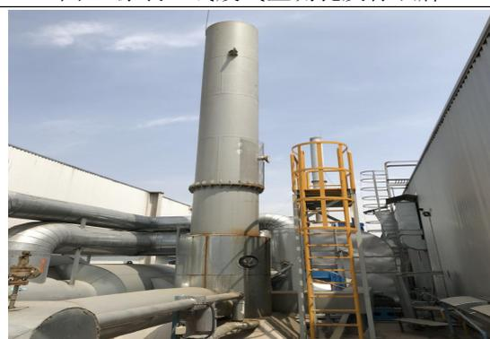
图 4 涂装二线废气监测孔、监测平台及爬梯
