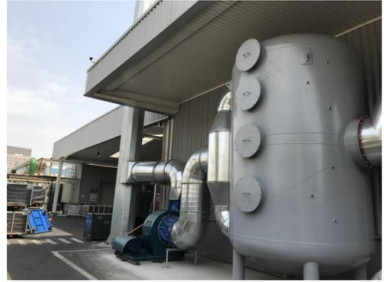
图 4 注塑废气活性炭吸附装置
