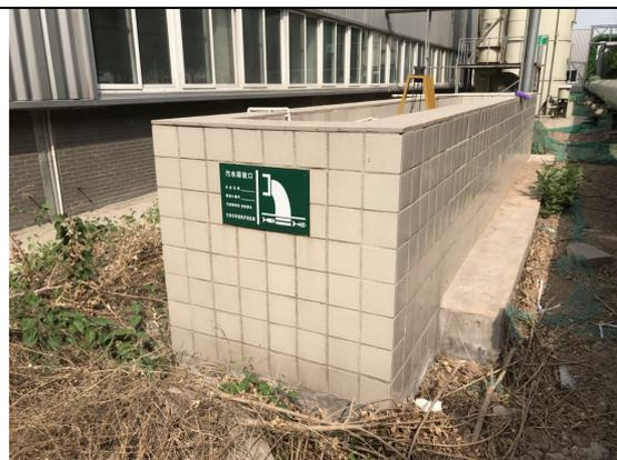
图 1 生产废水排水明渠及标识牌
