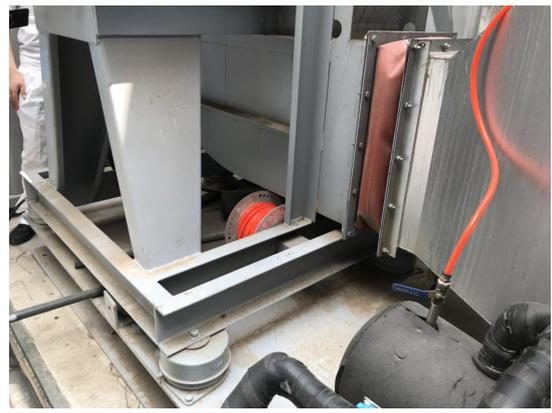
图 2 减振基础
