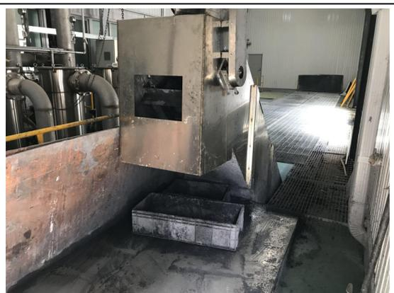
图 4 喷漆循环水池（漆渣池）
