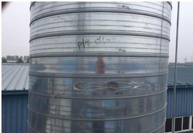
图2.排气筒P1监测孔
