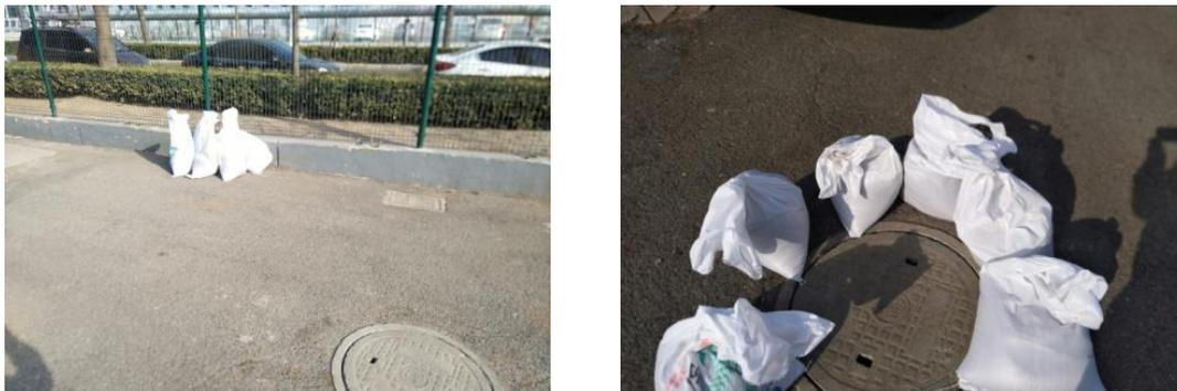
图 4.2-4 用于雨水排口封堵的沙袋
