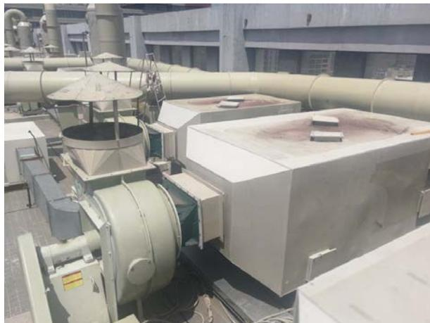
图6 有机废气活性炭吸附处理装置
