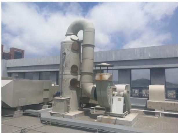
图5 酸性废气喷淋塔处理装置
