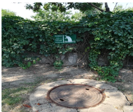
图 2 厂区废水排放口
