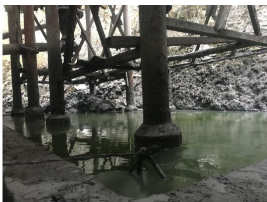
生产废水沉淀池
